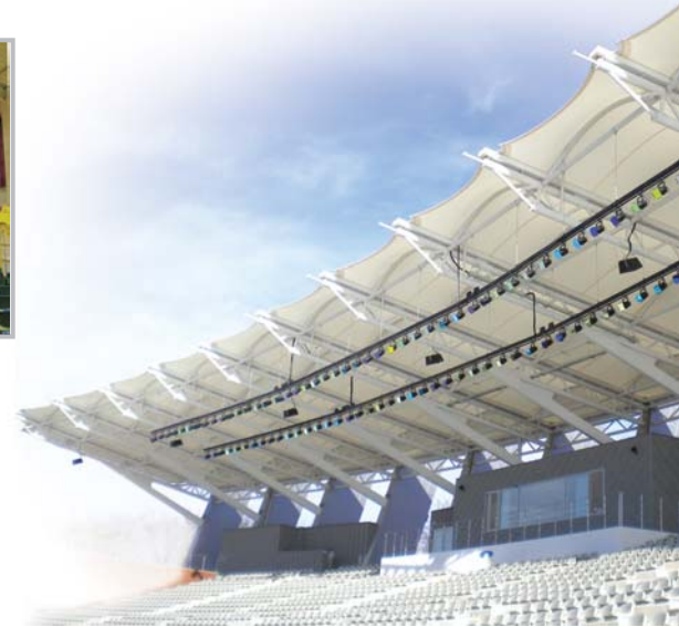
경주 보문단지 야외 음악당 시공
